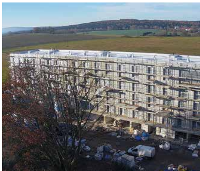
Bytový dům Pacov – výstavba
